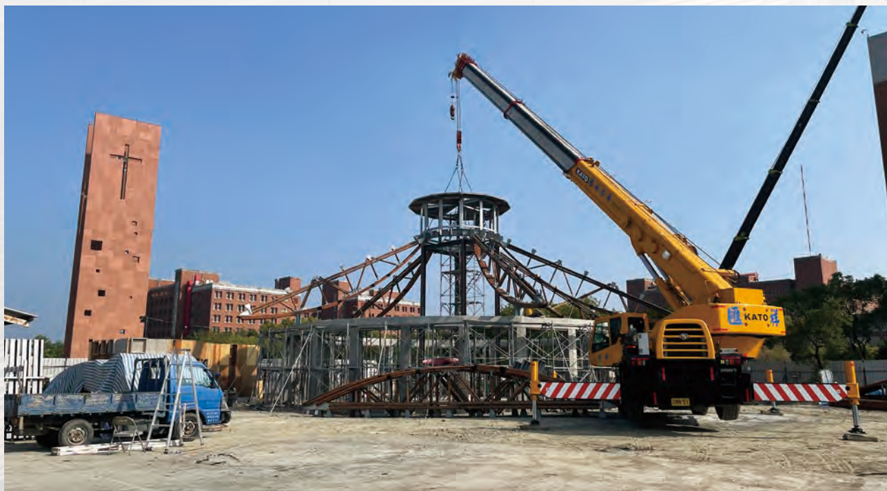
施工過程照片
