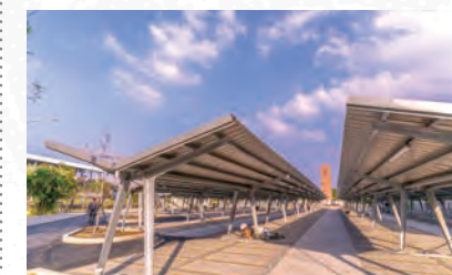
2021.12.6 第一機車停車場完工啟用
