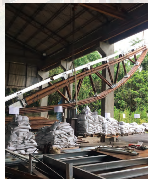
試驗照片-第二次試驗，竹桁架負重至五噸時
