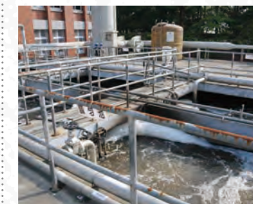
2004.5.26 污水處理場管理室完工
