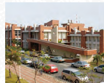
2003.8.26 土開實習工場及游藝樓完工
