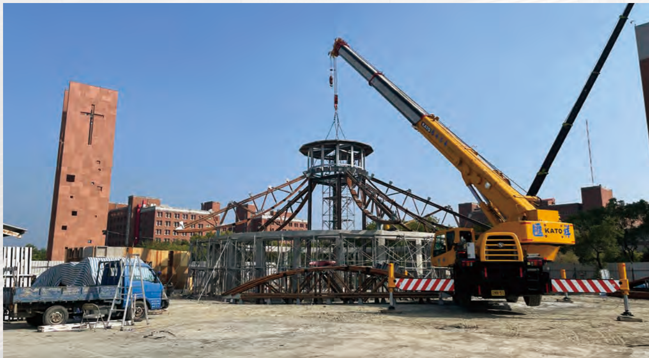
施工過程照片
